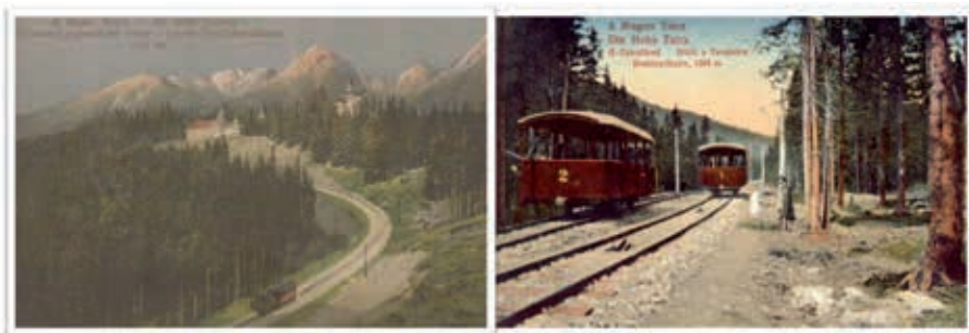
Obrázek 6 Na dobové pohlednici vlevo je závěrečný úsek ozubnicové železnice ze Štrby na Štrbské Pleso. Na pohlednici vpravo jsou zachyceny oba vagóny pozemní lanovky na Hrebionok při svém míjení ve výhybně v polovině trati.
